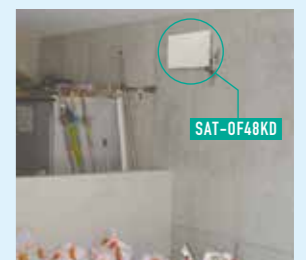
マンションゴミ置場
